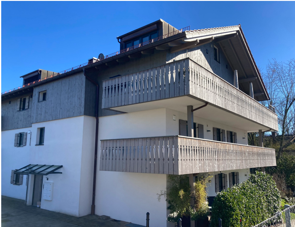
West - und Nordfassade
